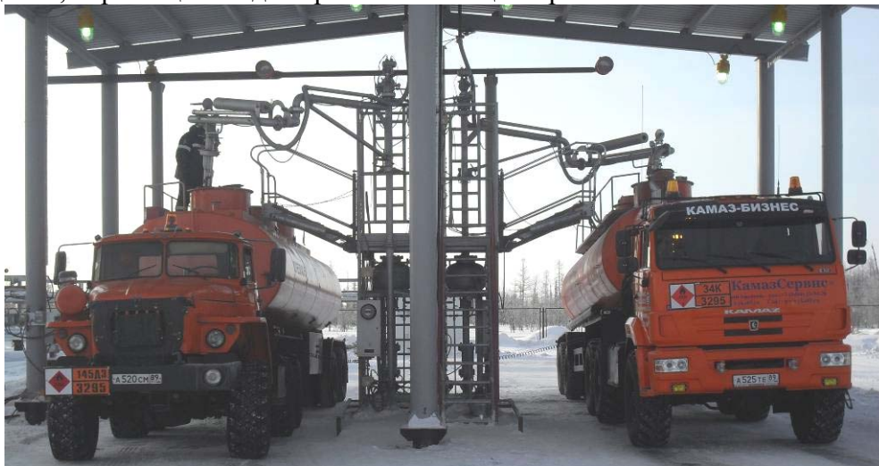
Измерительный комплекс АСН-10ВГ модуль Ду100 2/2
