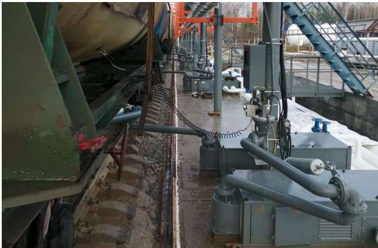
Рис. 3 – Стыковка установки УПН с Ж/Д цистерной
