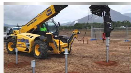
Монтаж винтовых свай
