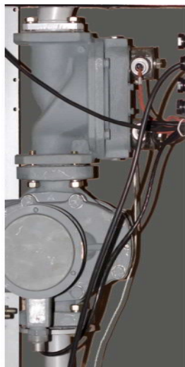
Счетчик жидкости ППО - измерение в единицах объема
