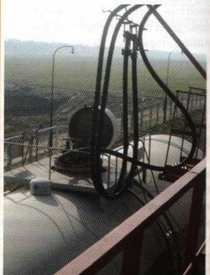
Рис. 1. Слив СУГ на ГНС: а – разделение сливно-наливного коллектора; б – подключение сливно-наливного рукава к железнодорожной цистерне; в – сливно-наливной рукав на железнодорожной цистерне
