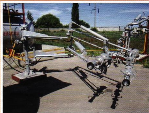
Рис. 3. Устройство для налива автоцистерн с быстроразъемными механизмами
